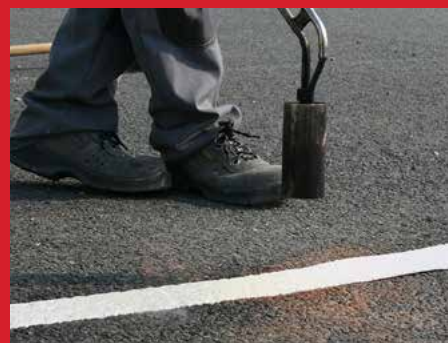
Termoplastické značení na asfalt a beton
