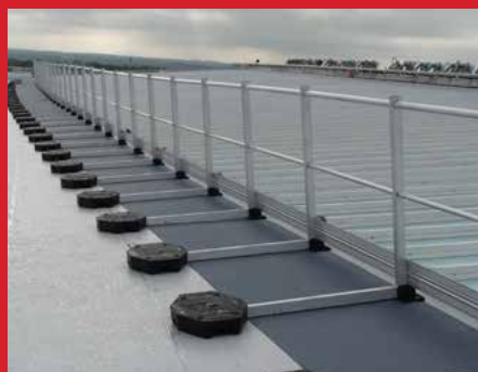
Střešní zábrany pro kolektivní ochranu
