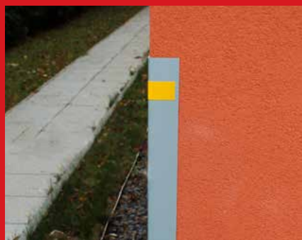
Slim PVC 65 na zateplené fasády
