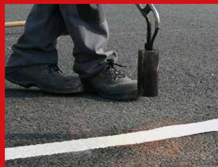
Termoplastické značení na asfalt a beton
